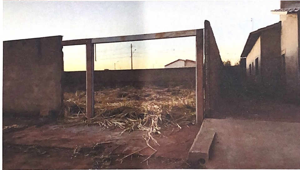
Laterais, frente e fundo murados em estrutura de alvenaria
